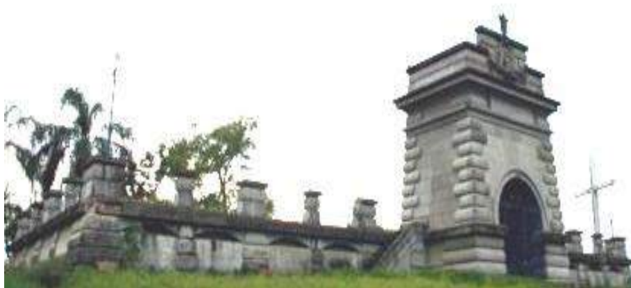
Caixa D'água do Portal.
