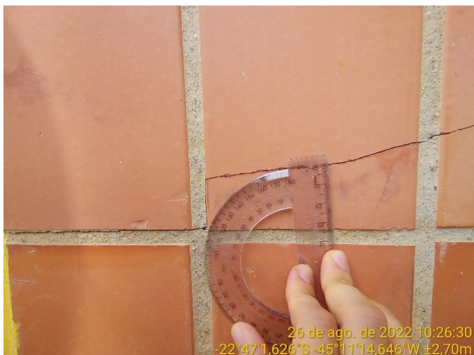
2.3 Trinca no revestimento cerâmico da parede externa
