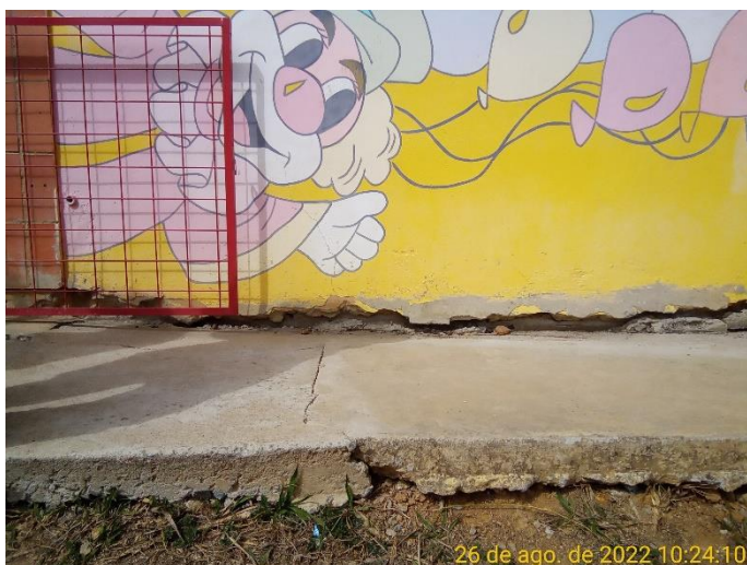
1.3 Vão entre a calçada e a parede da escola criado pela movimentação da edificação
