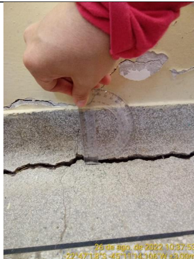
10.3 Detalhe piso sala de aula com rachadura
