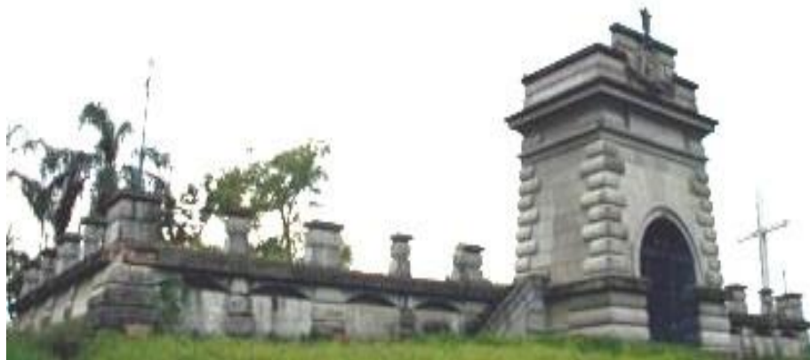
Caixa D'água do Portal.
