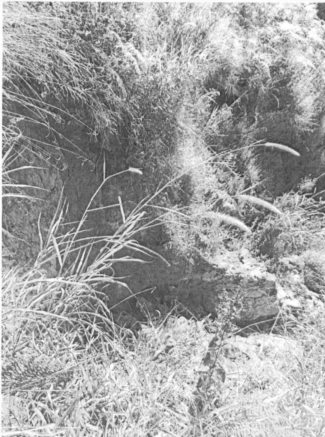
Visão do topo do talude (Ponto 2)
