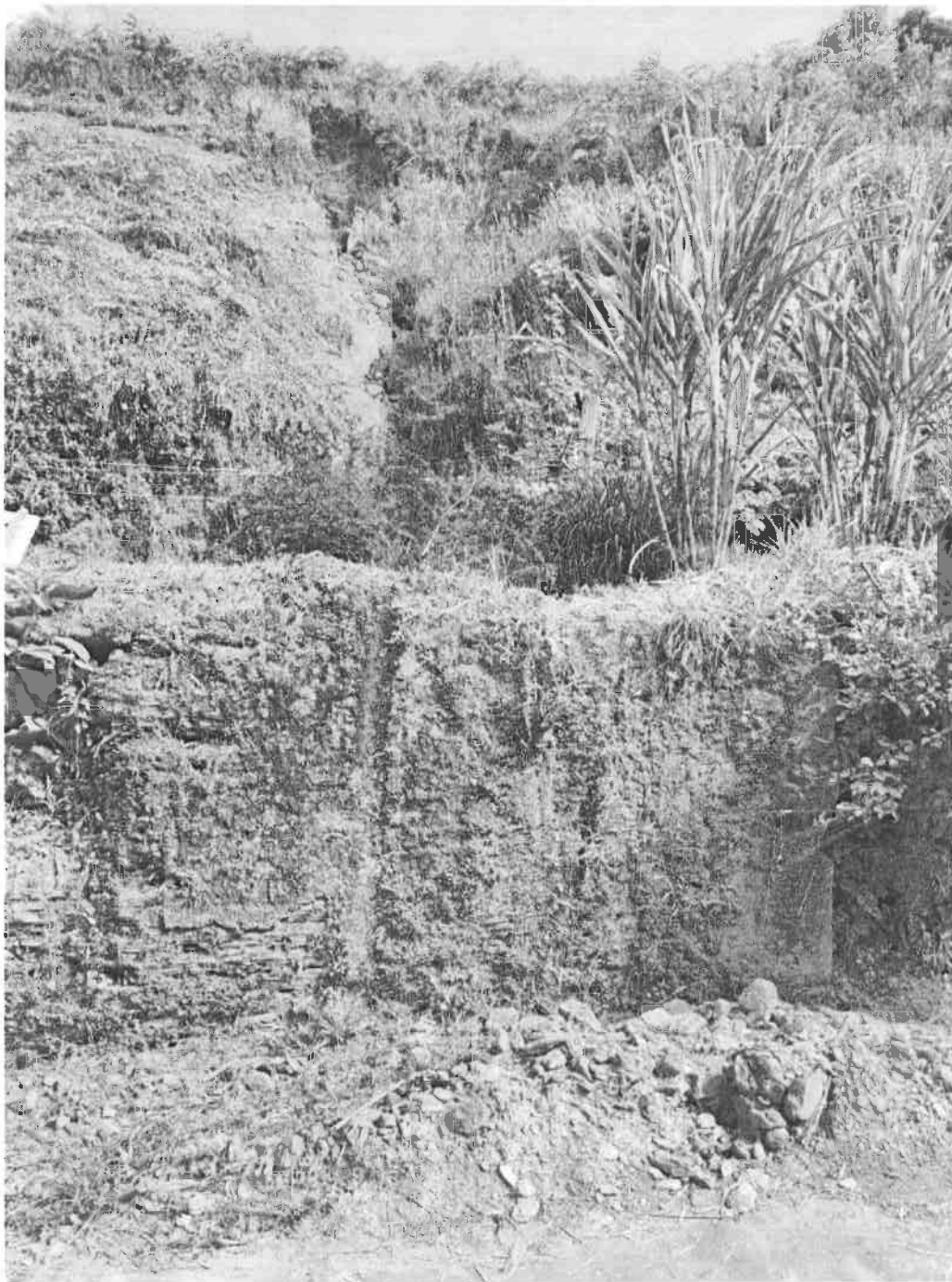
Visão da base do talude (Ponto 2)
