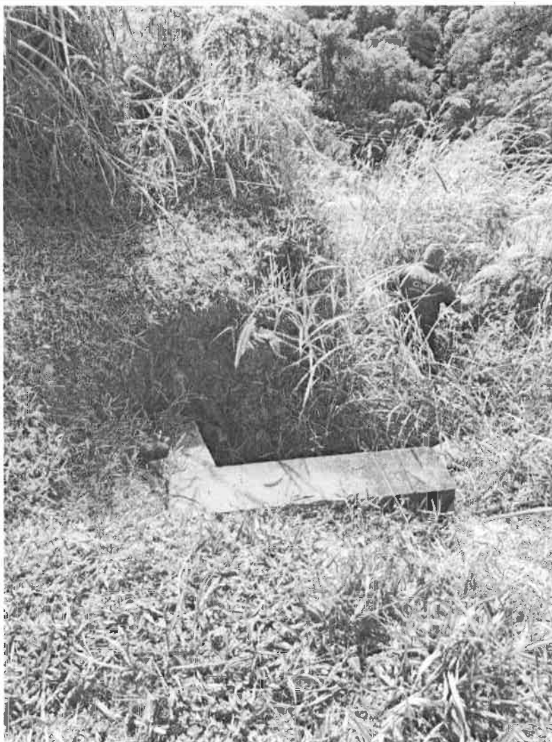
Saída da drenagem – Ponto 3
