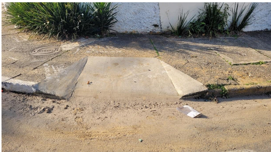
Imagem 06 – Vistoria 12/09/2024 – Rampa de acessibilidade Av. Min. Salgado Filho com a Rua Célio Ribeiro dos Santos – – Inclinações incorretas, sem distância mínima para raio de manobra e obstáculos.
