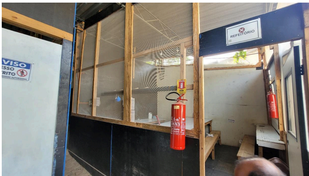
Imagem 04 – Vistoria 09/09/24 – Canteiro de obras em tapumes, refeitório.
