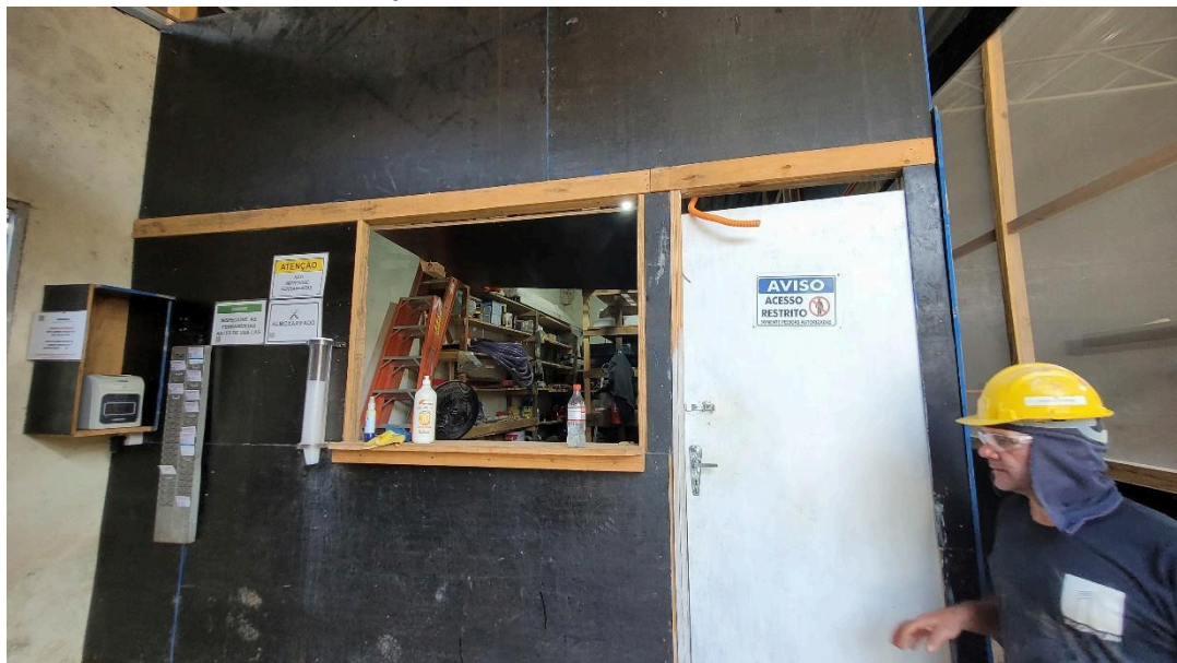
Imagem 03 – Vistoria 09/09/24 – Canteiro de obras em tapumes, almoxarifado.
