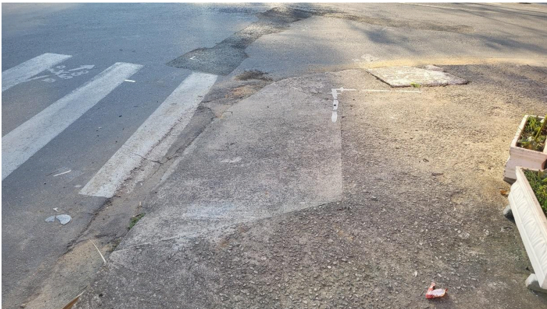
Imagem 08 – Vistoria 12/09/2024 – Rampa de acessibilidade Av. Min. Salgado Filho com a Rua Faustino Moreira – Inclinações incorretas.
