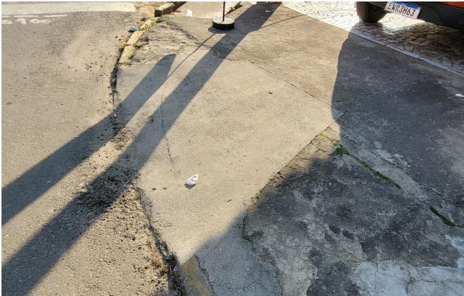
Imagem 02 – Vistoria 12/09/2024 – Rampa de acessibilidade Av. Min. Salgado Filho com a Rua Miguel Pereira – Inclinações incorretas.
