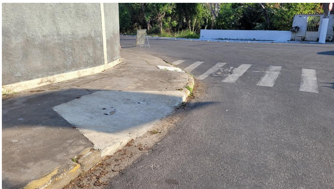
Imagem 03 – Vistoria 12/09/2024 – Rampa de acessibilidade Av. Min. Salgado Filho com a Rua Mario Pernambuco – Inclinações incorretas e sem distância mínima para raio de manobra.
