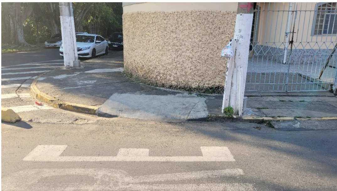
Imagem 10 – Vistoria 12/09/2024 – Rampa de acessibilidade Av. Min. Salgado Filho com a Rua Faustino Moreira – Inclinações incorretas, sem distância mínima para raio de manobra e obstáculos.
