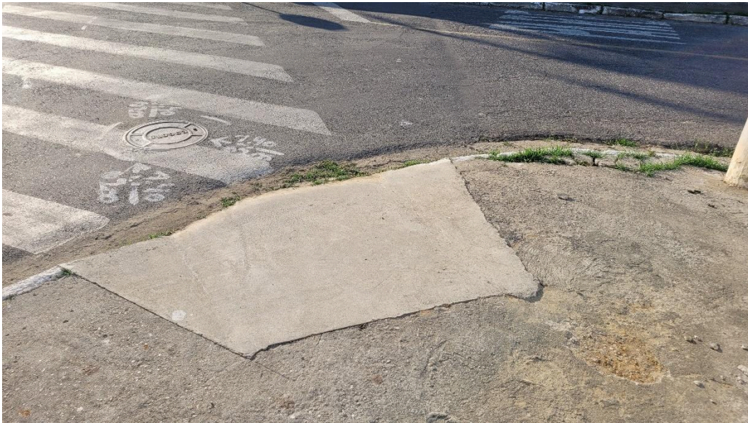
Imagem 07 – Vistoria 12/09/2024 – Rampa de acessibilidade Av. Min. Salgado Filho com a Rua Antônio Nelson Ribeiro dos Santos – Inclinações incorretas.
