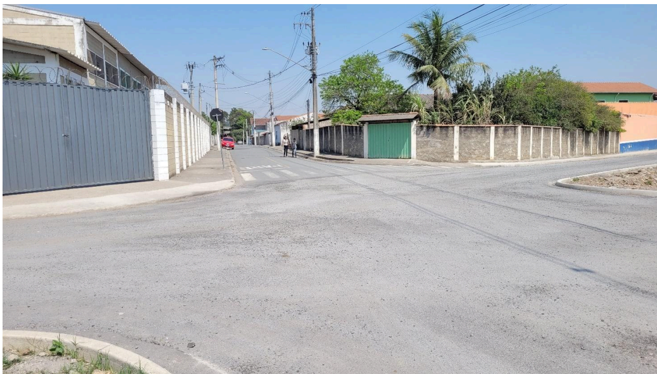
Imagem 20 – Vistoria 13/09/2024 – Bairro Vila Bela.
