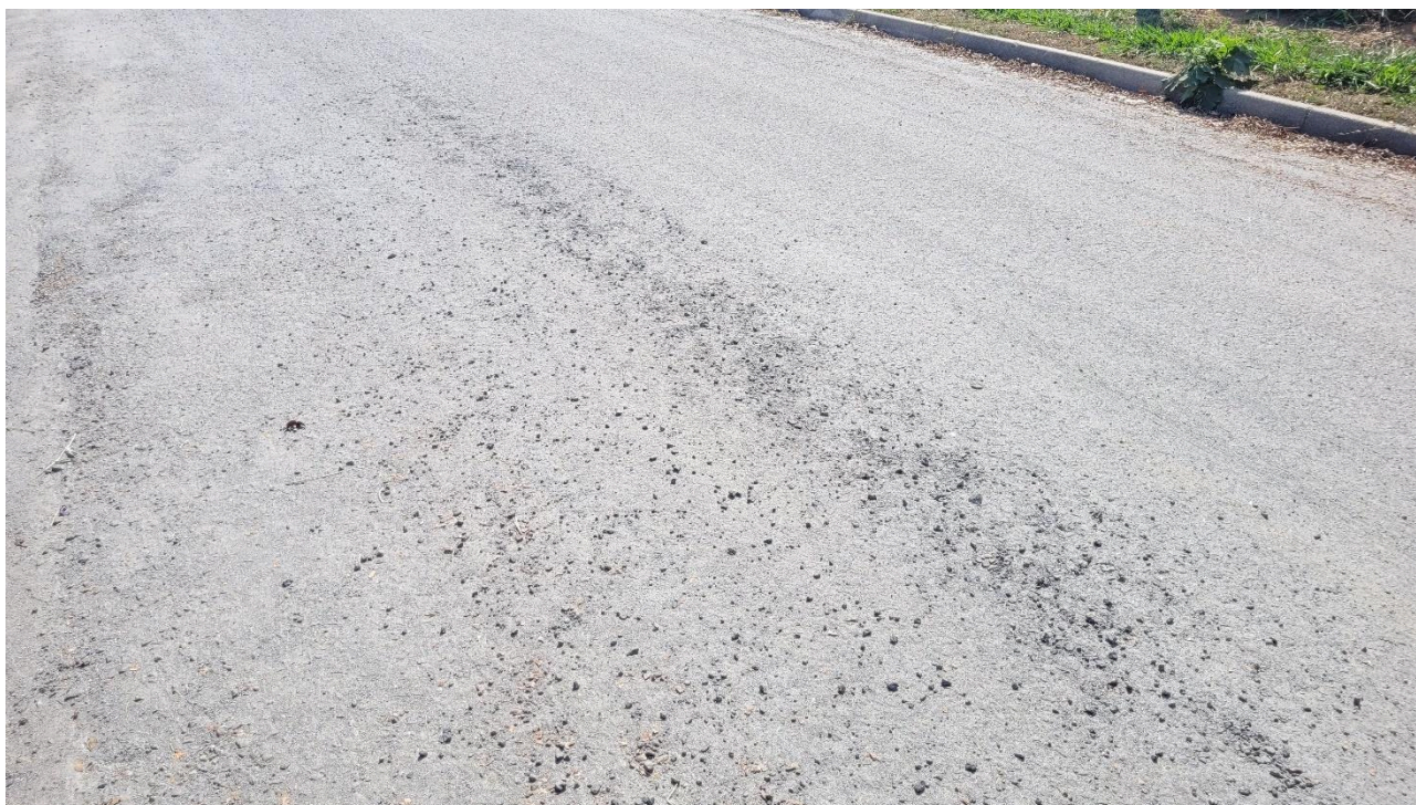
Imagem 12 – Vistoria 13/09/2024 - Bairro Pingo De Ouro.
