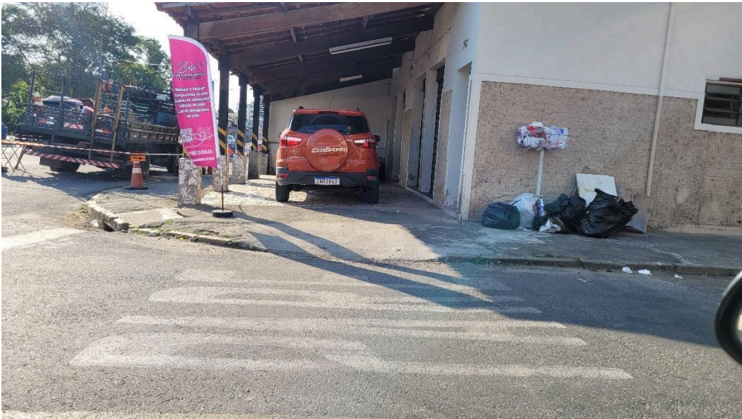
Imagem 01 – Vistoria 12/09/2024 – Rampa de acessibilidade Av. Min. Salgado Filho com a Rua Miguel Pereira – Inclinações incorretas.
