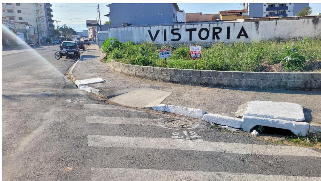
Imagem 04 – Vistoria 12/09/2024 – Rampa de acessibilidade Av. Min. Salgado Filho com a Rua Arinor da Fonseca Pereira – Inclinações incorretas e sem distância mínima para raio de manobra.
