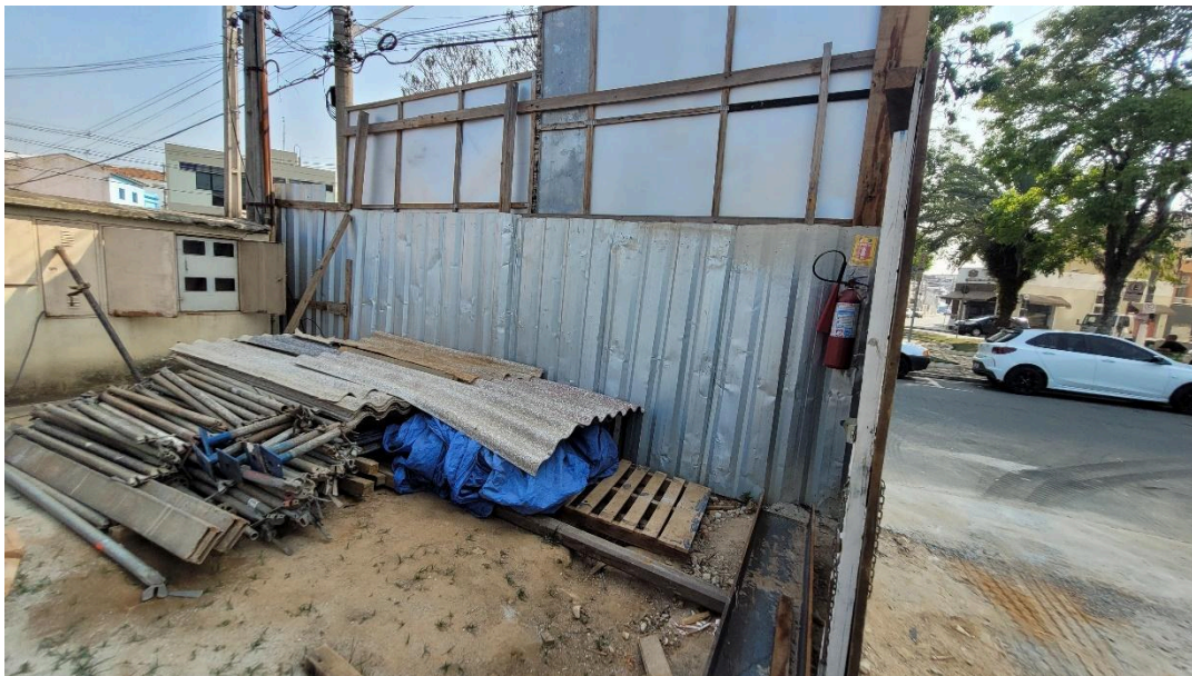
Imagem 02 – Vistoria 09/09/24 – Fechamento da obra em telha metálica, vista interna.
