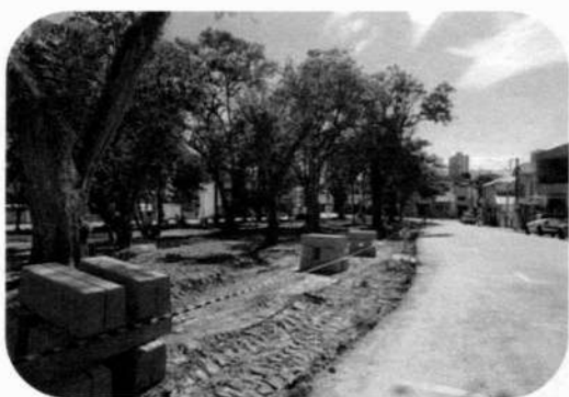
DEMOLIÇÃO E GUIAS
