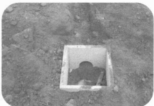
ASSENTAMENTO DE TUBO
