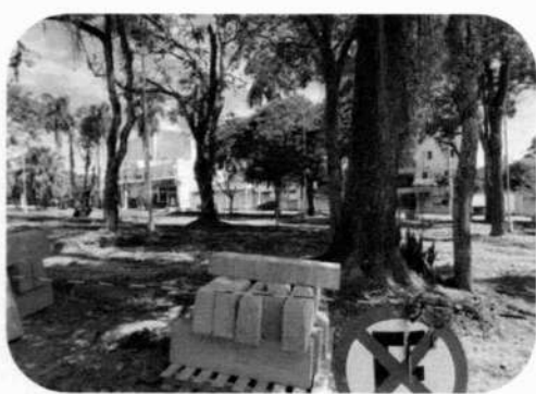
DEMOLIÇÃO E GUIAS
