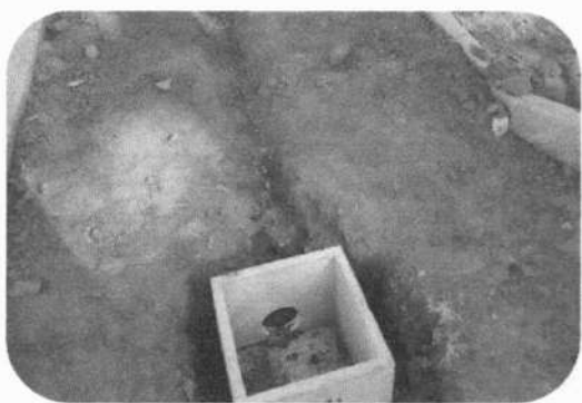
INSTALAÇÃO DE CAIXA
