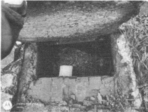
DESOBSTRUÇÃO DE BL
