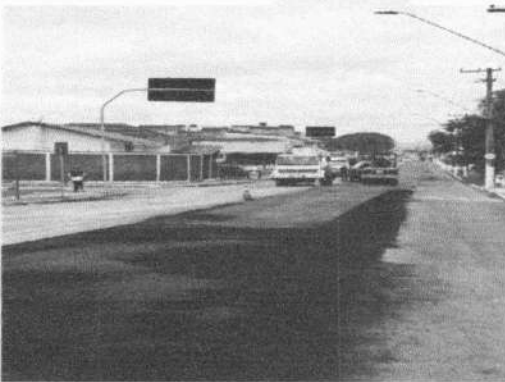
RECAPEAMENTO ASFÁLTICO
