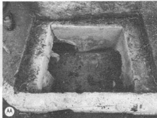
DESOBSTRUÇÃO DE BL
