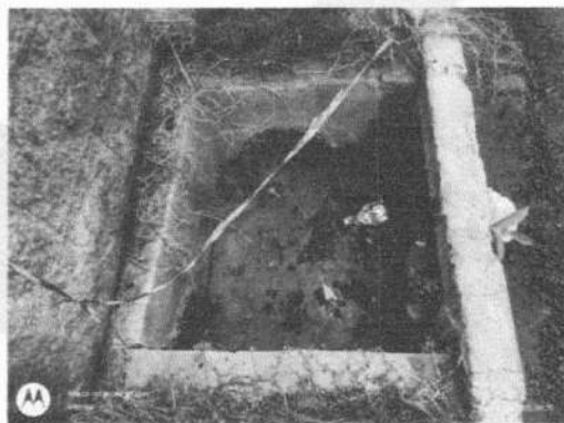
DESOBSTRUÇÃO DE BL
