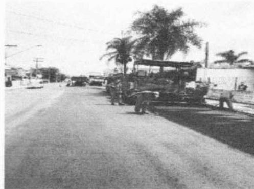
RECAPEAMENTO ASFÁLTICO
