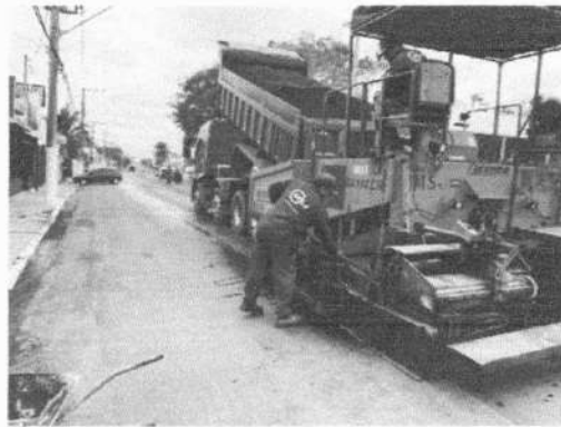
RECAPEAMENTO ASFÁLTICO
