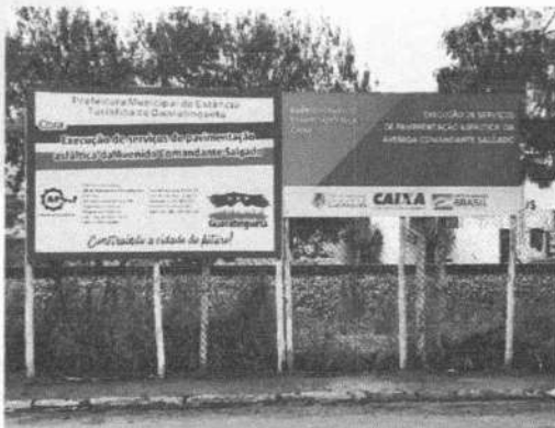
PLACA DE OBRA
