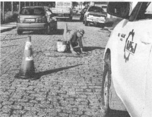
NIVELAMENTO DE PV
