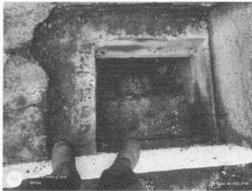
DESOBSTRUÇÃO DE BL
