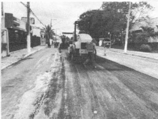
RECAPEAMENTO ASFÁLTICO
