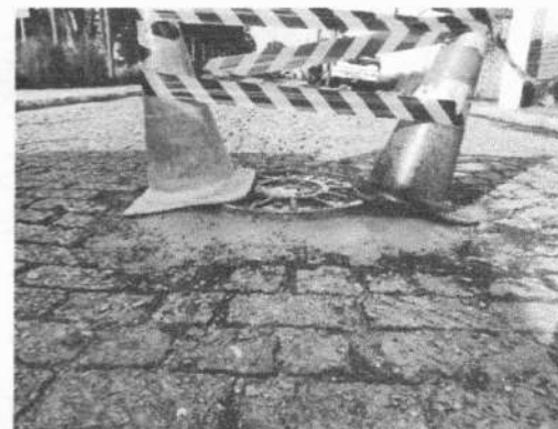
NIVELAMENTO DE PV
