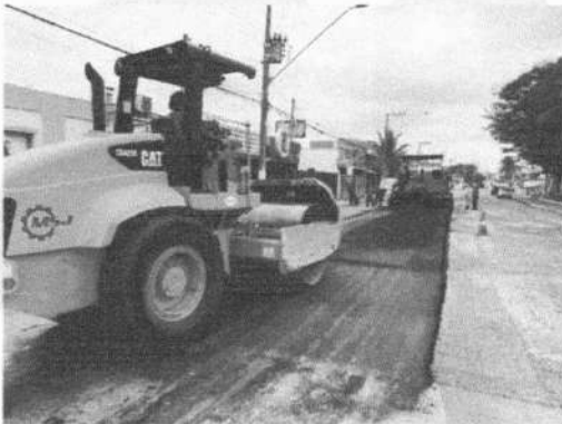
RECAPEAMENTO ASFÁLTICO
